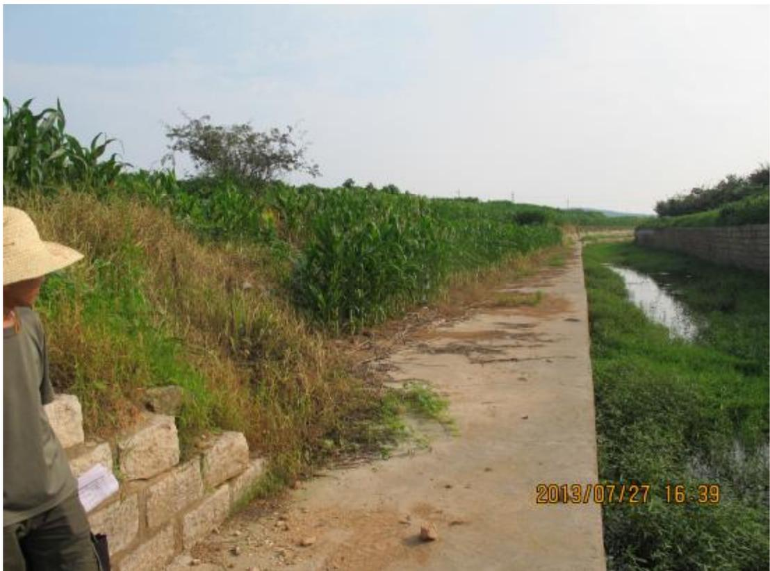
总干渠护砌段损坏严重
