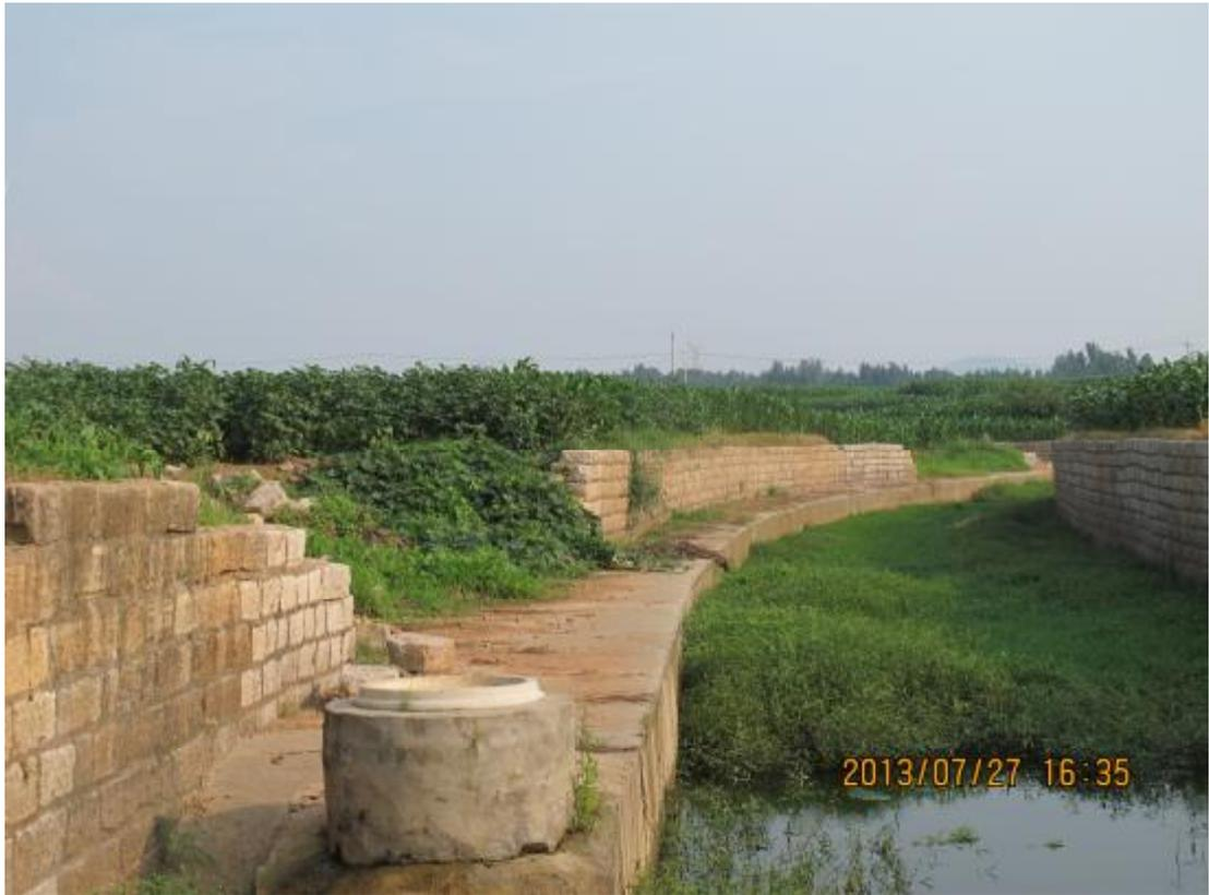
总干渠护砌段损坏严重
